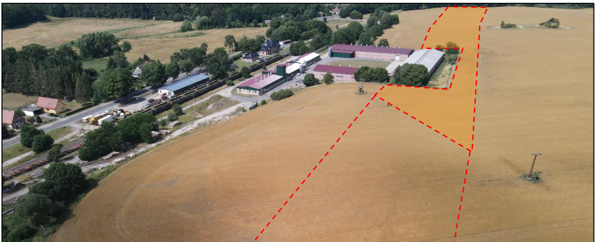
Abbildung 3: Planteil 3; Blickrichtung Westen (Planungsraum rot skizziert)
