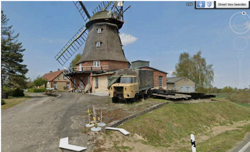
Abbildung 12: Foto von L16 auf Windmühle; Wohnhaus im Hintergrund [Quelle: Google Earth, street view]
