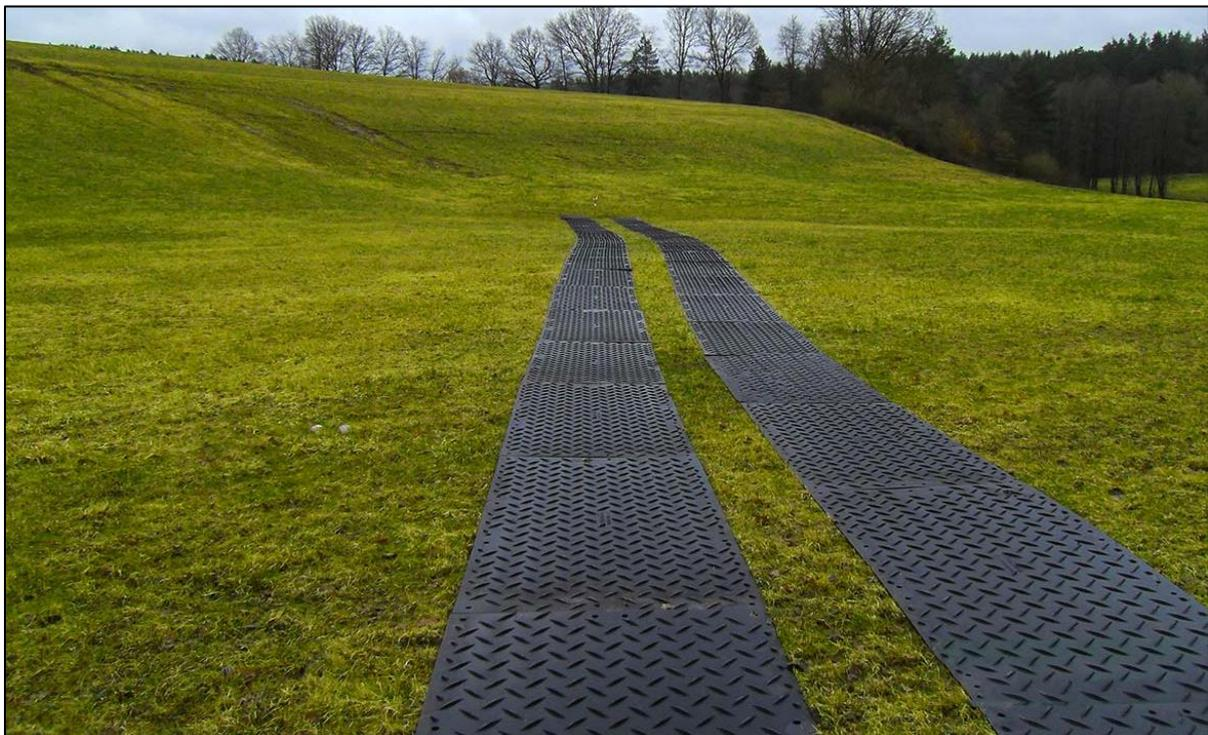
**Abbildung 22:** Beispielfoto mobile Baustraße zur Vermeidung von Bodenverdichtung (<https://www.securatek.de/Referenzen/s-tek-48-Hochleistungs-Bodenschutzplatte-als-Mobile-Baustrasse-beim-Rohrleitungsbau-bei-Creussen-in-Bayern>)
