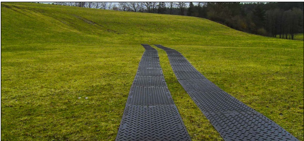
Abbildung 12: Beispielfoto mobile Baustraße zur Vermeidung von Bodenverdichtung ( https://www.securatek.de/Referenzen/s-tek-48-Hochleistungs-Bodenschutzplatte-als-Mobile-Baustrasse-beim-Rohrleitungsbau-bei-Creussen-in-Bayern )
