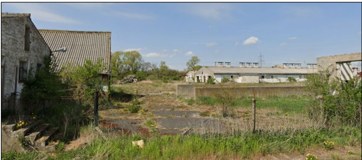
Abbildung 4: vorhandene Versiegelungen durch vorhergehende Nutzung, Google Streetview
