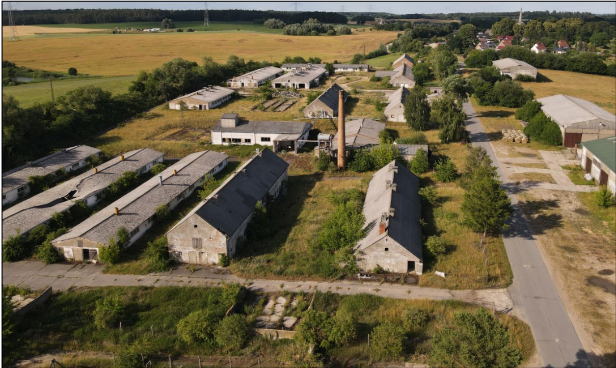
Abbildung 1: bestehende Stallanlage, Drohnenaufnahme Juli 2022
