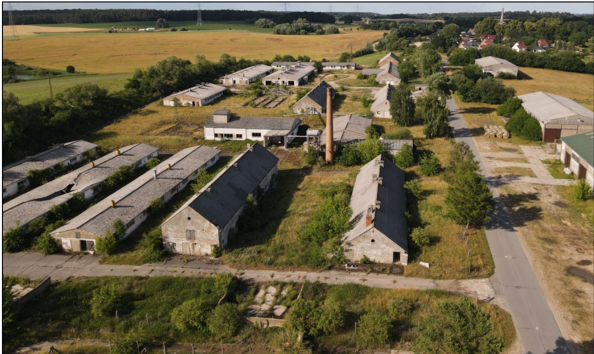
Abbildung 4: bestehende Stallanlage, Drohnenaufnahme Juli 2022
