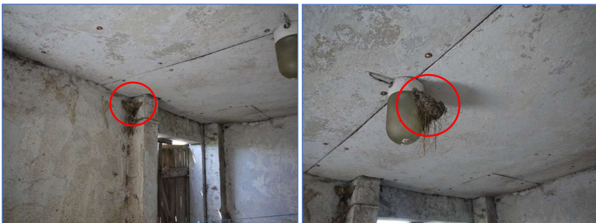
Abb. 2 und 3 Beispiele für Rauchschwalbennester in den Bestandsgebäuden
