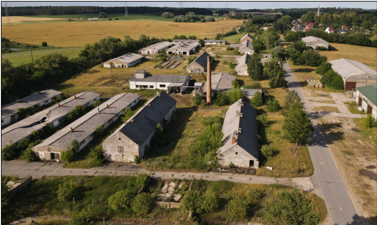
Abbildung 2: bestehende Stallanlage, Drohnenaufnahme Juli 2022
