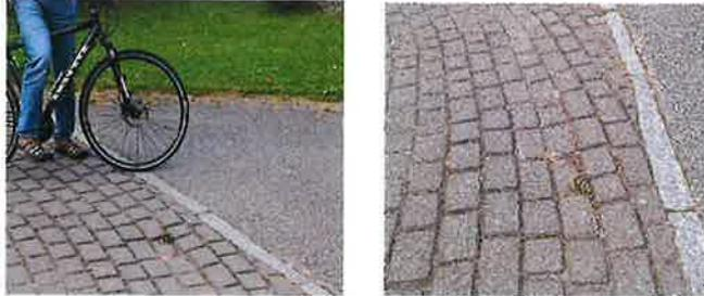
**Lösungsvorschlag: Bauhof öffnet Fläche, neuer Unterbau, Pflaster schließen, abrütteln. absanden**
