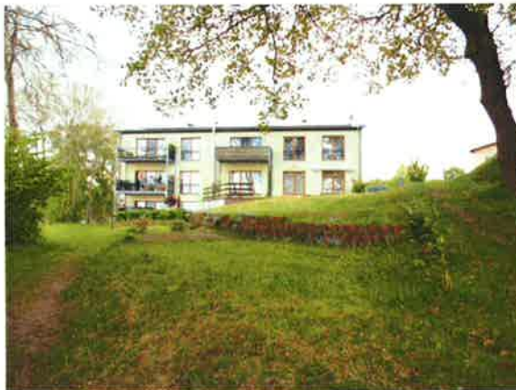
Bestehende Bebauung im Norden des Plangebiets
