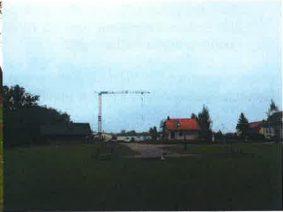
Neubebauung im mittleren Teil des Plangebietes.
